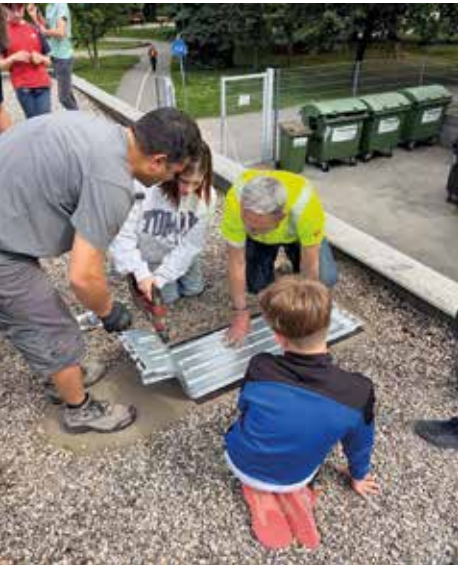
Technik zum Anfassen: Jugend-liche der Europa-sport-Mittelschule in Mödling beim Aufbau einer Photovoltaik-Anlage.
